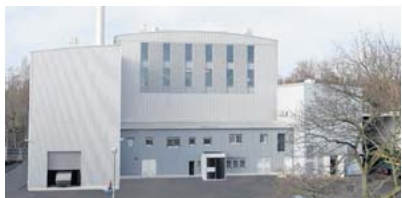
Das neue Frischholz-Heizkraftwerk der Stadtwerke an der Gerhard-Malina-Straße kann am Samstag besichtigt werden. FOTO: STADTWERKE
